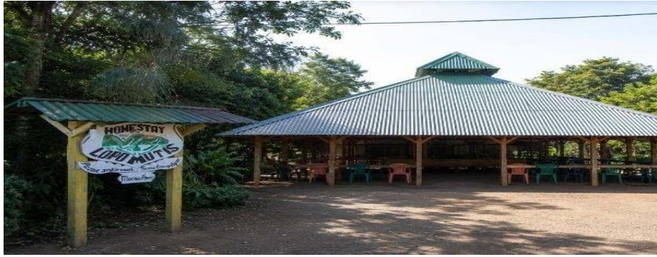
Gambar 1. Dokumentasi awal berdirinya bangunan Lopo Mutis Babnain di Desa Fatumnasi.
