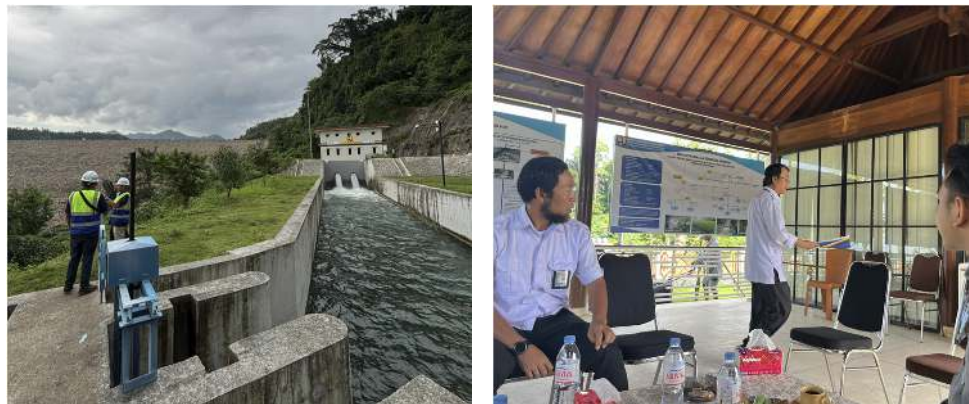
Gambar 4. Dokumentasi inspeksi lapangan dan koordinasi teknis dalam evaluasi RTD. Paket Implementasi Prioritas
